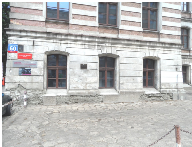
Widok zniszczeń cokołów na elewacji frontowej
