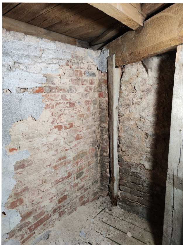
Zniszczony, spróchniały słupek drewniany podtrzymujący belkę krawędziową dachu (narożnik budynku pom. 4.03.)
