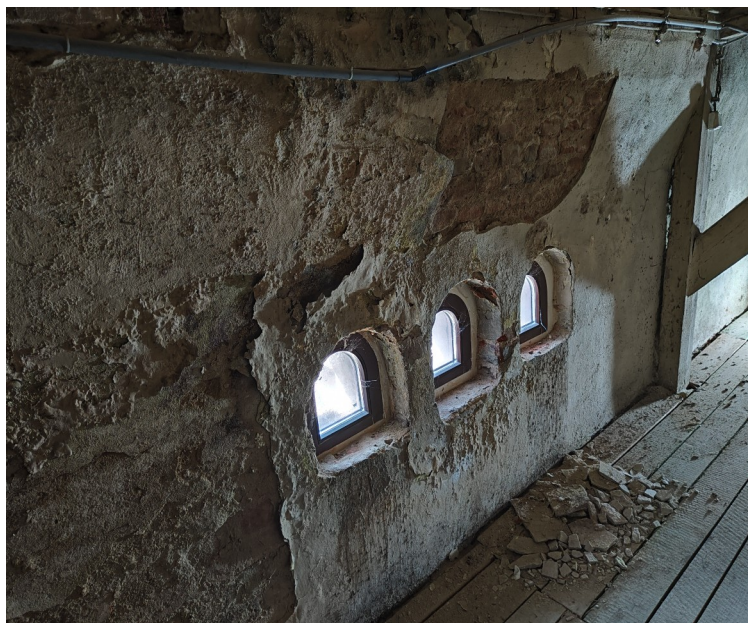
Zniszczona na skutek przecieków z dachu ściana poddasza – pom. 4.06. (zniszczenia oparć belek stropowych)
