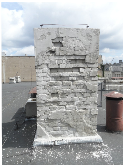
Widoczne zniszczenie jednego z kominów.
