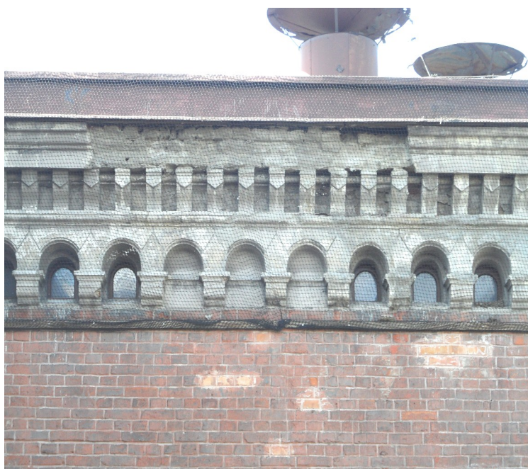
Widok zniszczonego gzymsu ozdobnego
