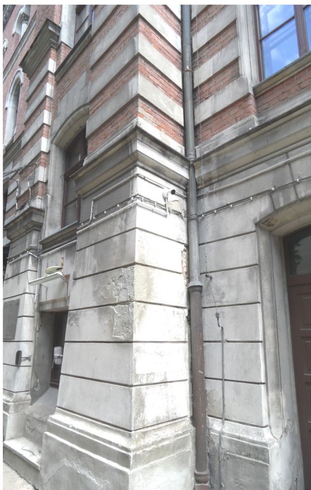
Widok zniszczonych tynków elewacji zachodniej.
