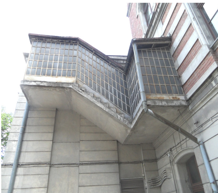
Widoczne zniszczenia obudowy schodów zewnętrznych do auli
