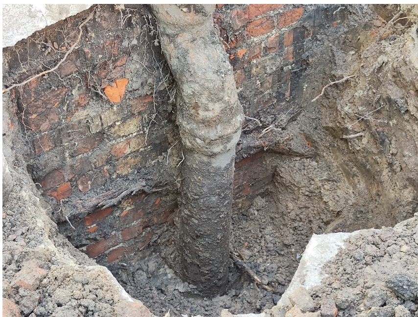
Odkrywka rury spustowej w gruncie.
