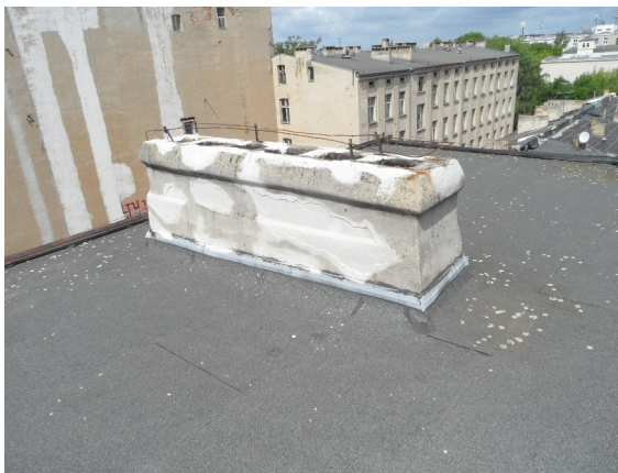
Widoczne ślady naprawy komina.
