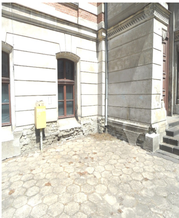
Widok zniszczeń cokołów na elewacji frontowej, przy wejściu głównym
