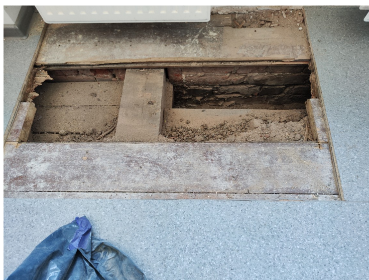
Odkrywka stropu nad I piętrzem (widoczne warstwy stropu)
