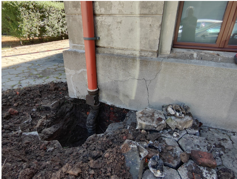
Odkrywka rury spustowej narożnika północno-zachodniego przybudówki
