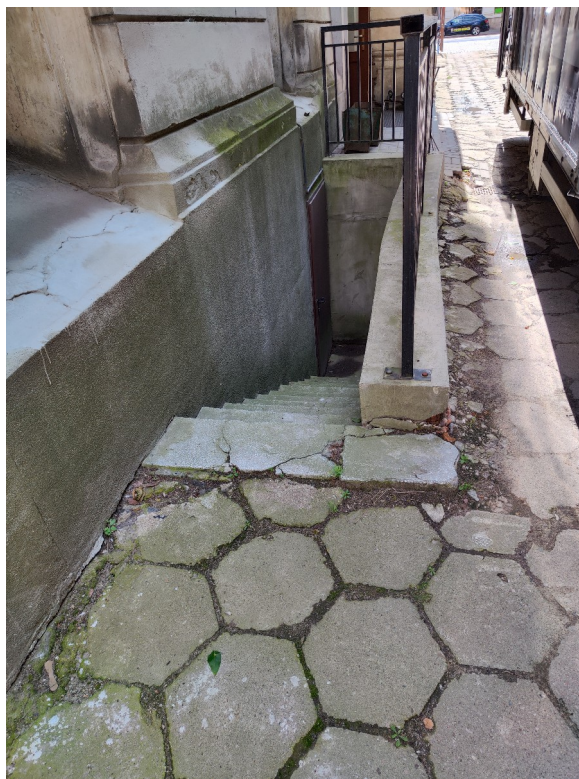
Widok schodów zewnętrznych wejścia do piwnicy z wybrzuszoną murem oporowym.
