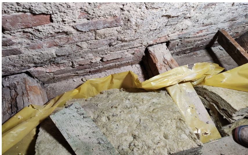
Widoczne zniszczone oparcie belek na murze.
