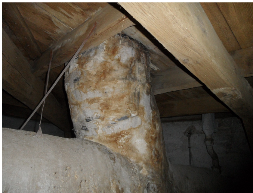
Widoczne przecieki dachu w miejscu przejścia instalacji.
