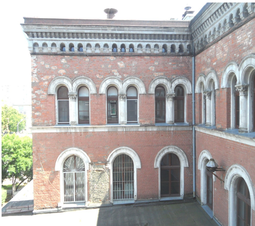
Widok przemurowań i napraw oblicówki
