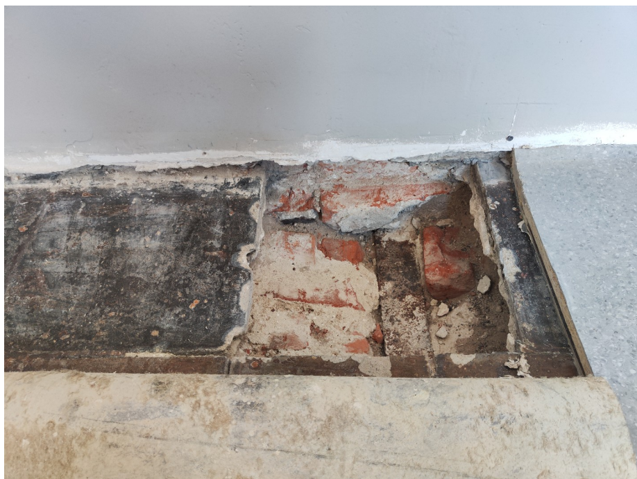
Odkrywka stropu odcinkowego na korytarzu II piętro.
