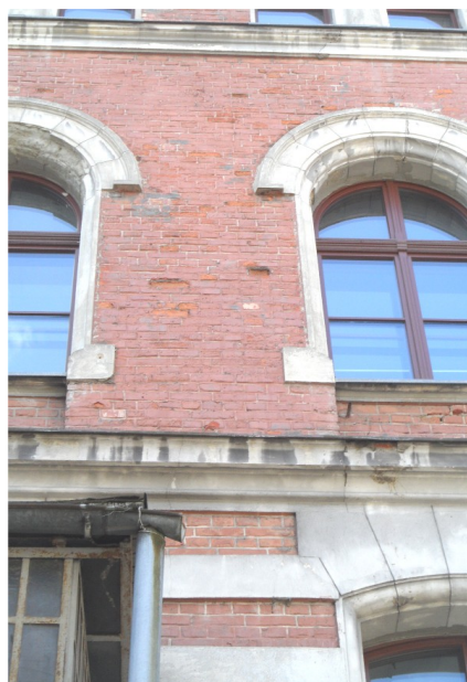
Widoczne ubytki w warstwie oblicówki oraz pęknięcia gzymsów
