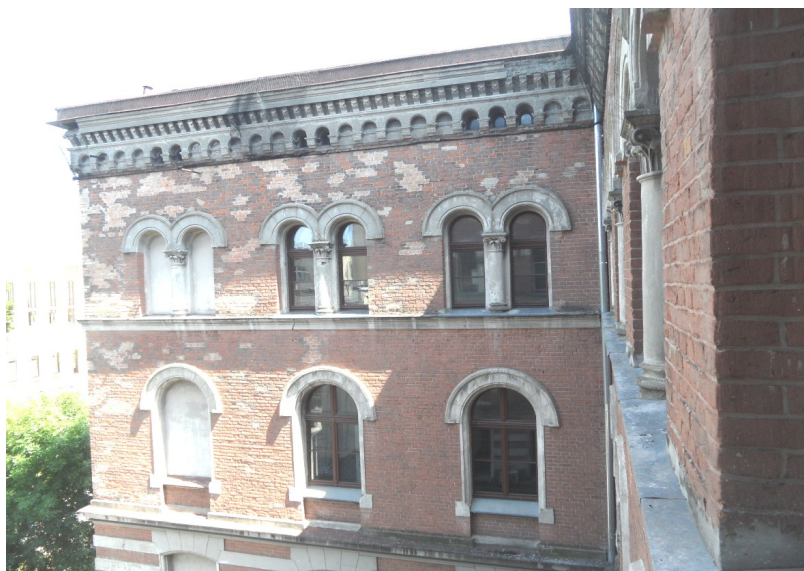
Widok napraw oblicówki i zniszczonego narożnika dachu
