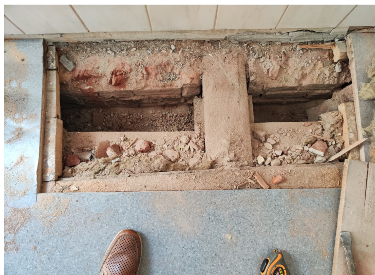
Odkrywka stropu nad I piętrzem (widoczne warstwy stropu)
