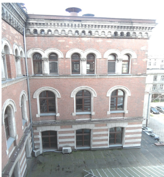
Widok zniszczonego gzymsu i napraw oblicówki
