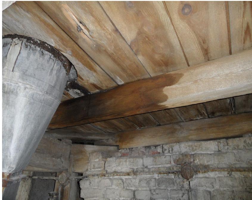
Widoczne przecieki dachu w miejscu przejścia instalacji.
