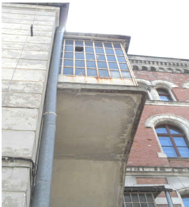
Widoczne zniszczenia obudowy schodów zewnętrznych do auli
