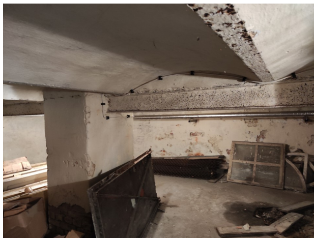
Widok podciagu stalowego stropu odcinkowego z oparciem na słupie murowanym.
