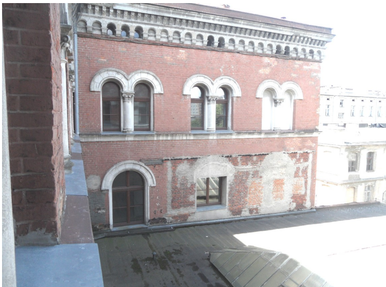
Widoczne przemurowania otworów okiennych
