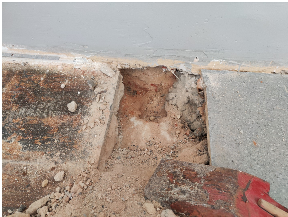
Odkrywka stropu odcinkowego na korytarzu II piętro.
