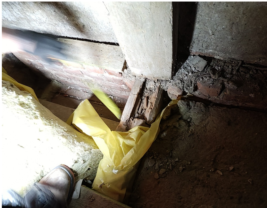
Widoczne zniszczone oparcie belki i słupka na murze.
