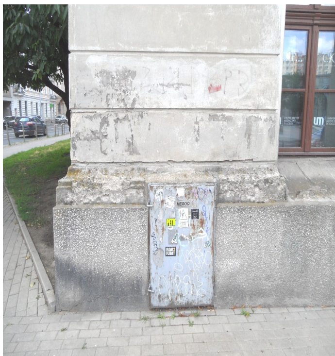
Widoczne zniszczenia tynku na cokole budynku
