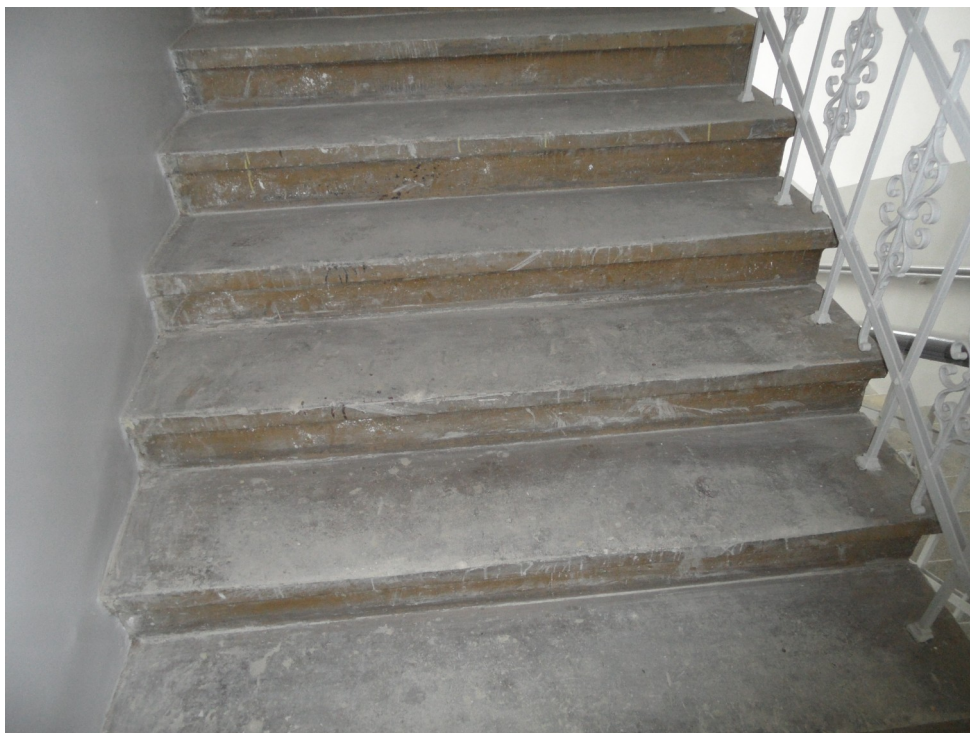
Widok biegu schodów. Widoczne miejscowe uszkodzenie stopni.
