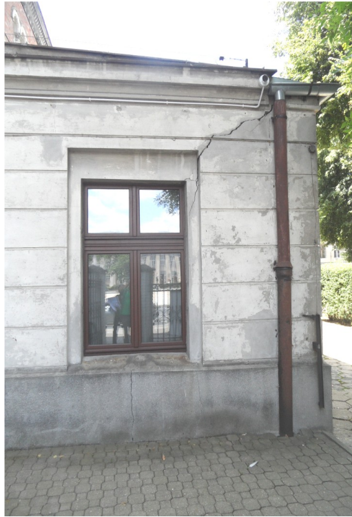
Widoczne pęknięcie na ścianie parterowej przybudówki
