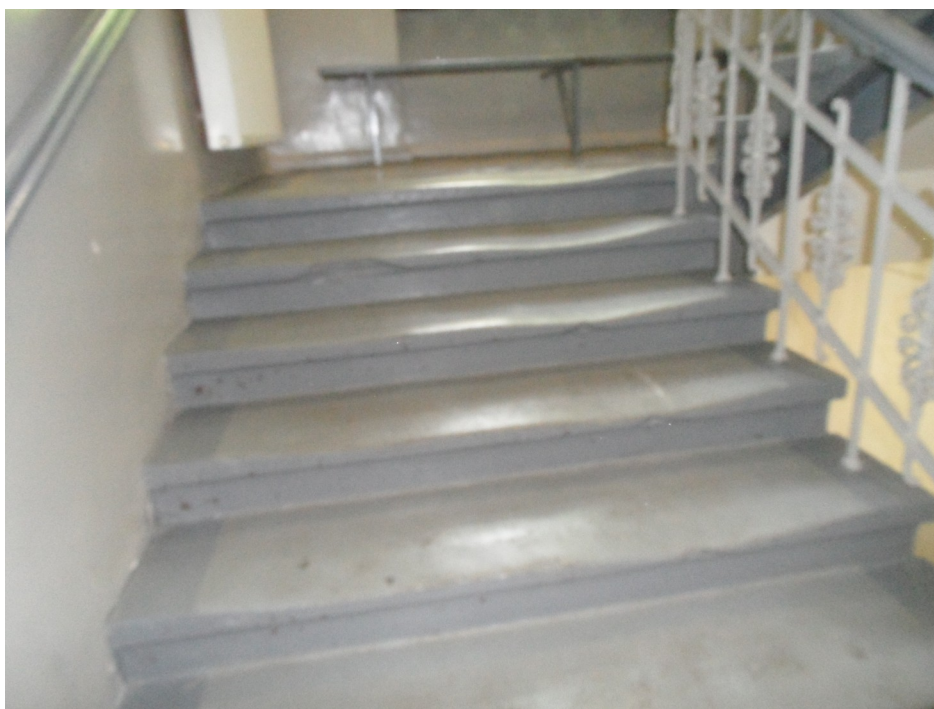
Widok biegu schodów. Wytarte i miejscowo zniszczone stopnie schodów.
